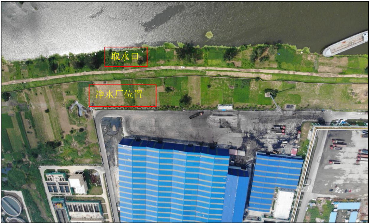
照片 1 项目区航拍图
